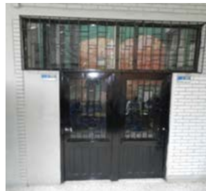
Figura 5. Ubicación de las puertas de las aulas C108 y C109, sobre la fachada.
